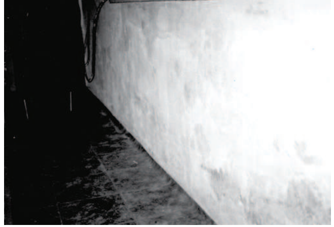
Rys. 13. Widok ściany po upływie trzech miesięcy od zakończenia prac preparatem Hermon (fot. własna)
