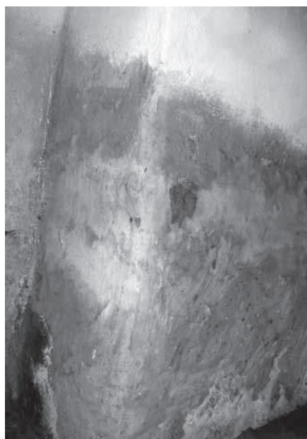
Rys. 2. Widok zawilgoconego muru betonowego – niżej oraz żelbetowego – wyżej przed przystąpieniem do prac osuszających Hermonem i schemat posadowienia ściany/fundamentu tego zawilgoconego obiektu (opracowanie własne)
