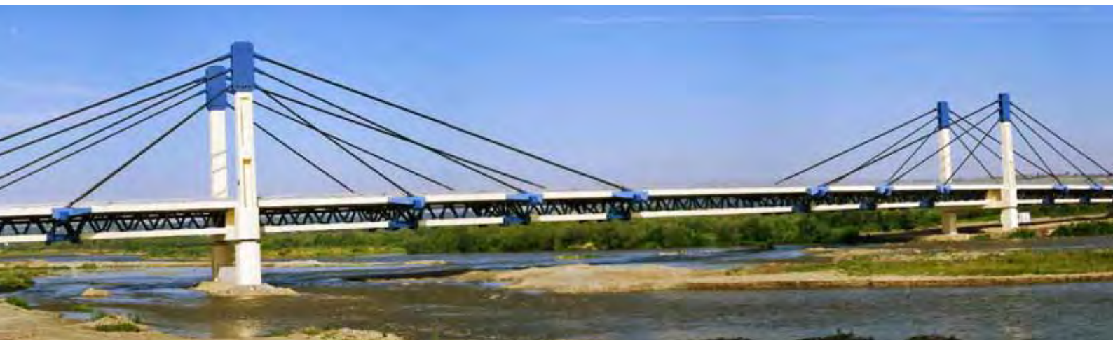
Most św. Kingi, zlokalizowany w ciągu obwodnicy Starego i Nowego Sącza
