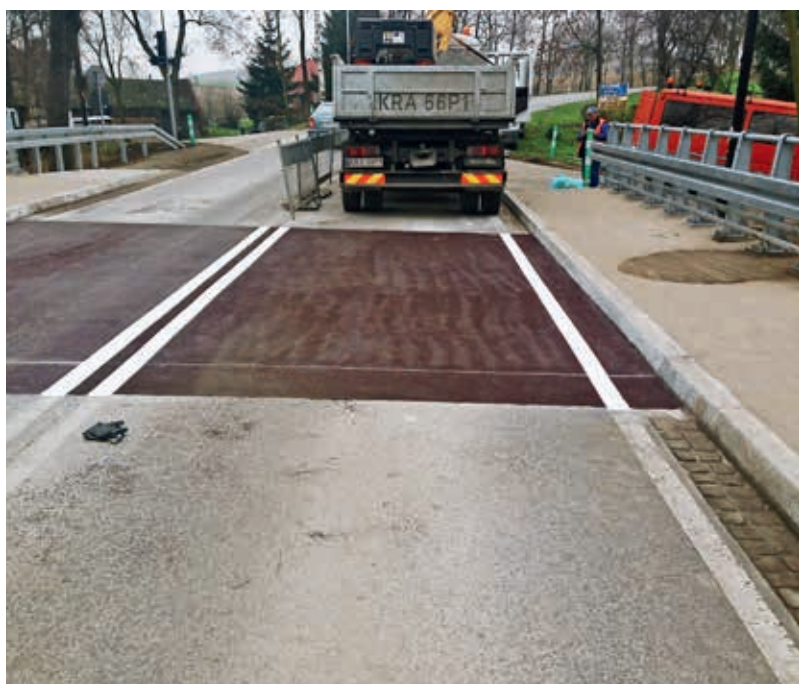
Most wykonany z innowacyjną izolacją-nawierzchnią
