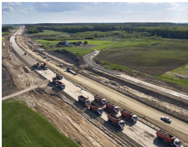
Rys. 5. Współpraca samochodów z równiarkami przy układaniu warstwy nawierzchni (fot. Kacper Kowalski/Forum)
