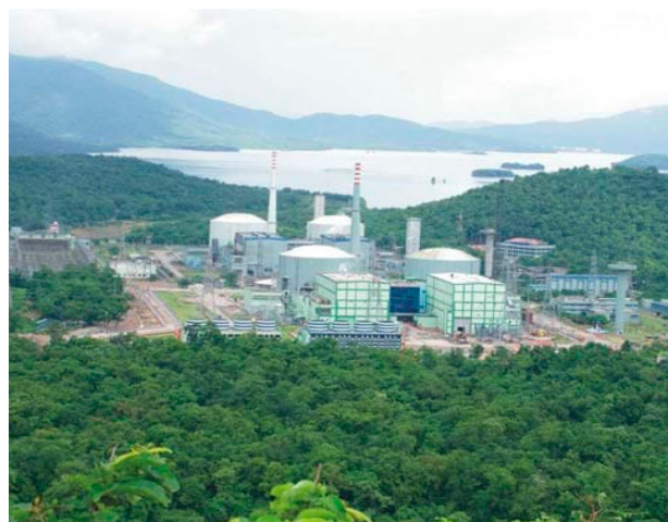
Fot. 3. Kompleks jądrowy Kaiga Photo 3. Kaiga nuclear complex ( www.ndtv.com india news)
