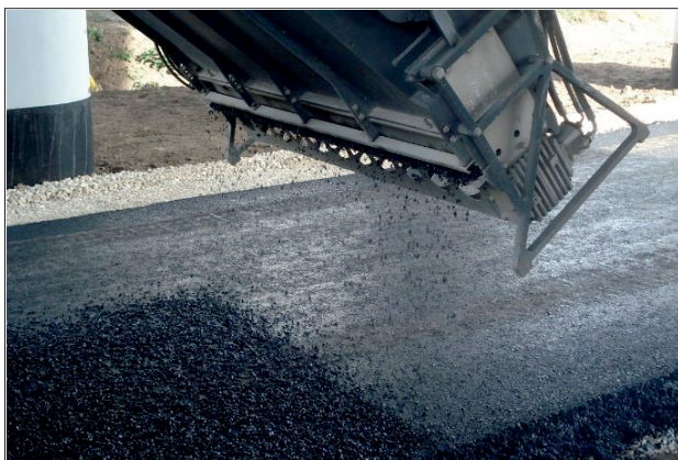
Fot. 2. Rozkładanie grysu lakierowanego na warstwę emulsyj. Bolimów, 2012 r. (fot. Piotr Świeżewski)
