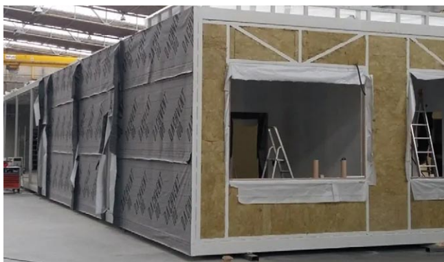
Rys. 3. Budowa modułu o konstrukcji szkieletowej stalowej (źródło: climatic.pl)
