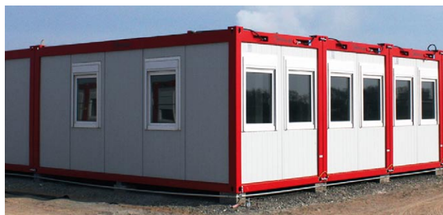
Rys. 5. Moduły kontenerowe ze ścianami panelowymi (źródło: modularsystem.pl)
