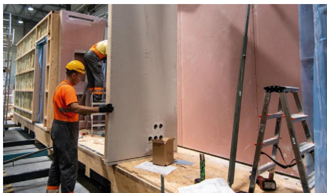
Rys. 1. Budowa modułu o konstrukcji drewnianej (źródło: unihouse.pl)
