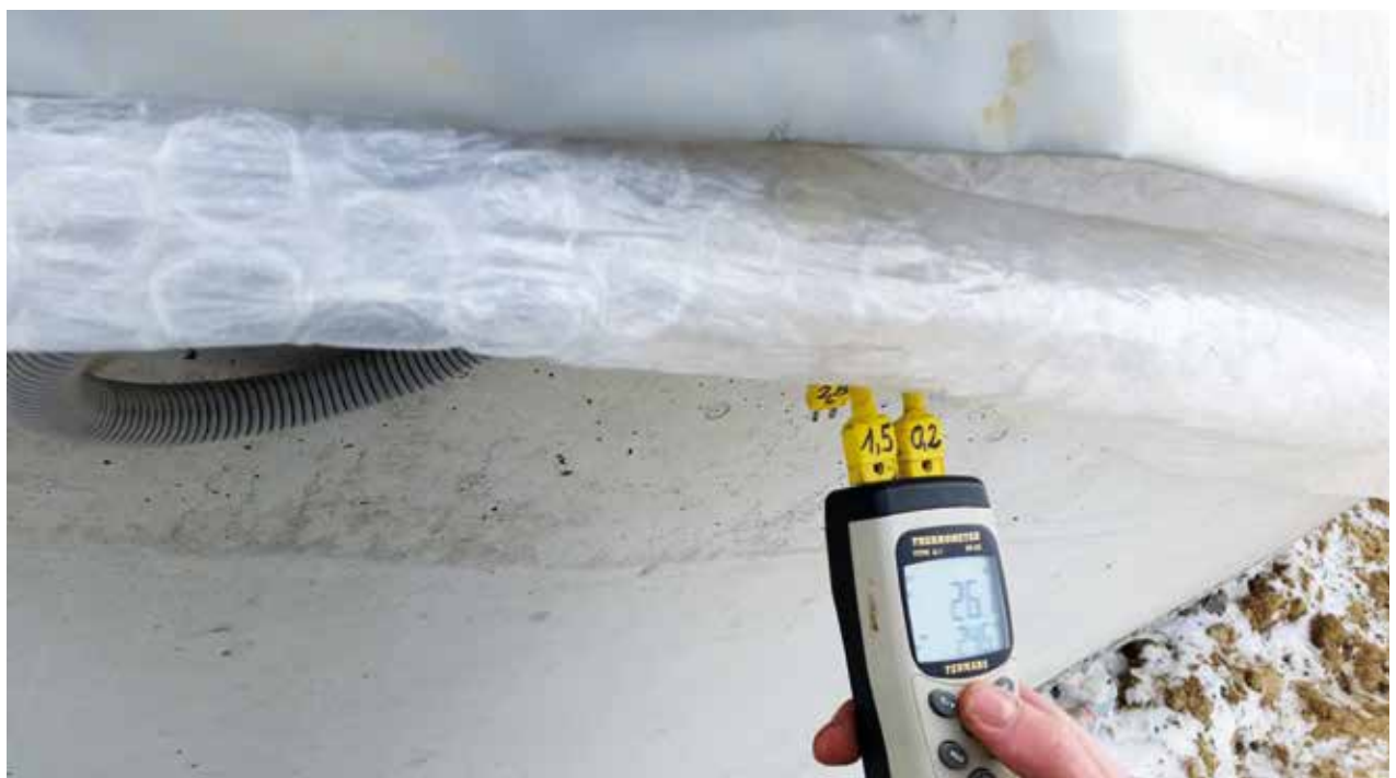
Rys. 2. Ręczny pomiar temperatury dojrzewającego betonu
