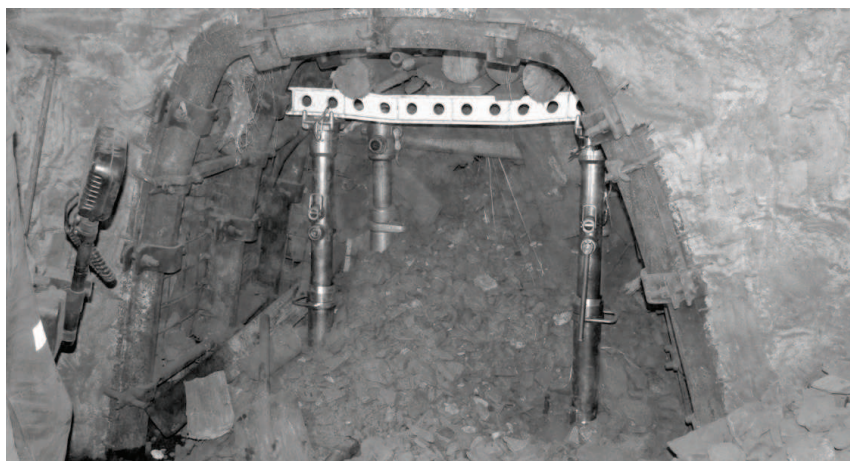
Rys. 7. Odrzvia obudowy HOR-01 zabudowane w wyrobisku ćwiczebnym CSRG [2]
