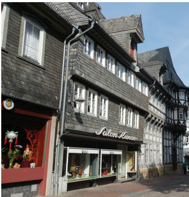
Il. 5. Goslar – lupek na elewacji maskujący drewnianą konstrukcję szkieletową (fot. D. Kowalska)
