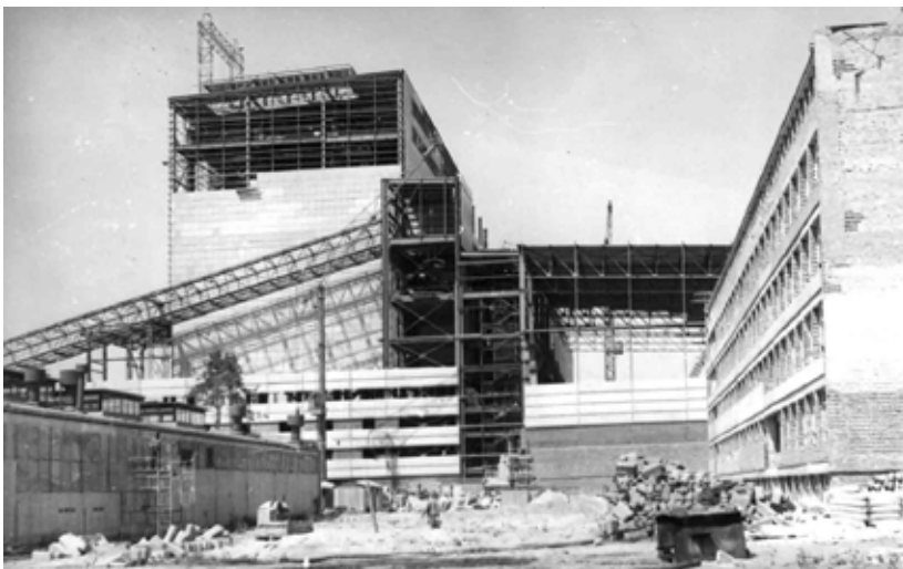
Budowa kotła i maszynowni pierwszego bloku energetycznego
