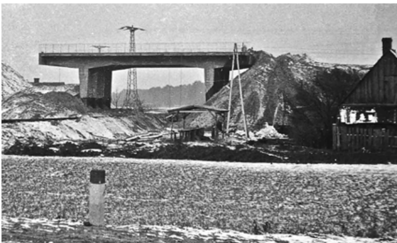
Budowa wiaduktu na trasie Kozienice - Aleksandrówka
