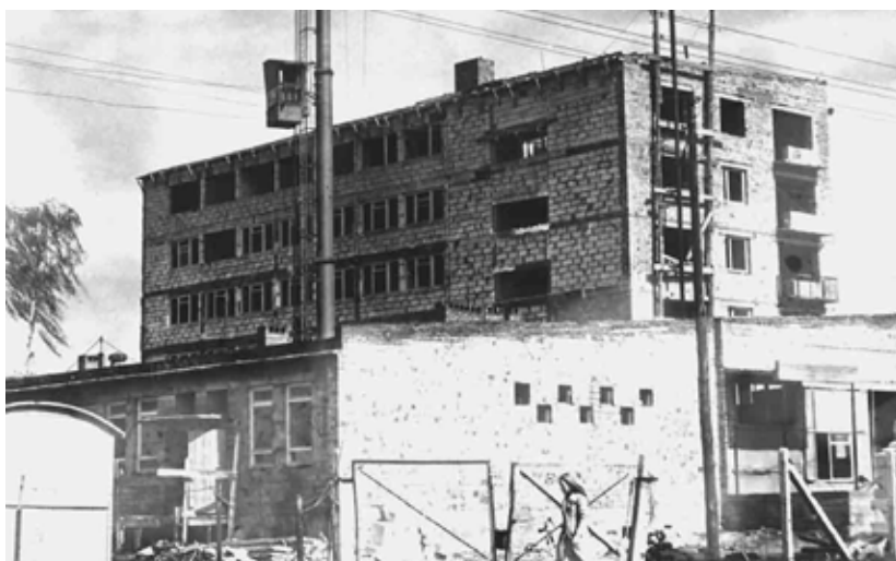
Budowa hotelu robotniczego „Energetyk”
