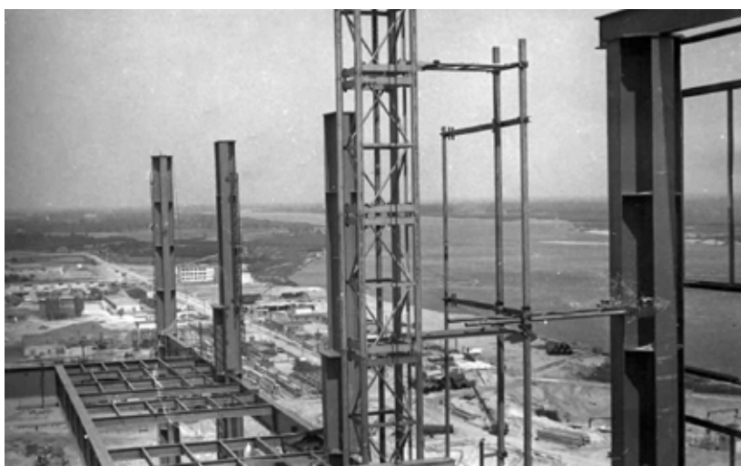
Pierwsze konstrukcje kotła
