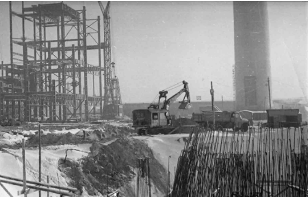
Budowa fundamentów bloku energetycznego
