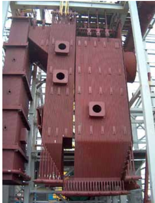
Rys. 4. Widok komory fluidalnej do spalania gazów pirolitycznych i karbonizatu w trakcie montażu na obiekcie.
