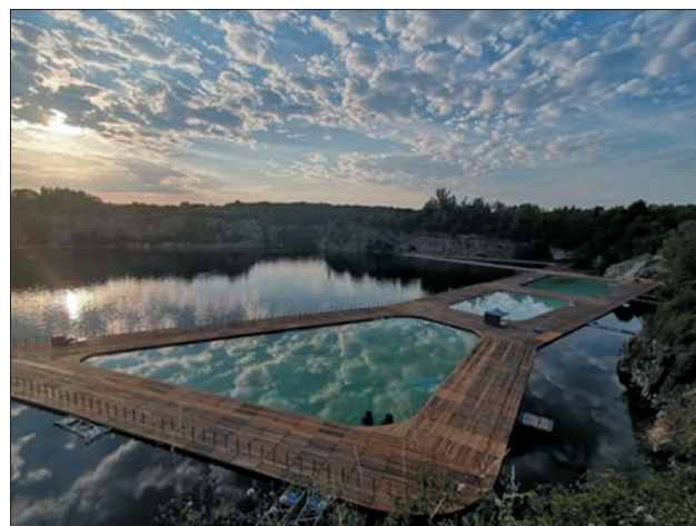
Ryc. 4. Budowa kąpieliska w kamieniołomie Zakrzówek w centrum Krakowa, 2022 r. Fot. A. Kot-Niewiadomska
