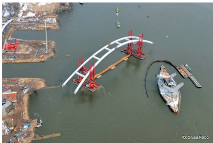
Fot. 7. Transport północnego przęsła nr 1 Źródło: Miejski Zarząd Dróg w Toruniu . Autor: Grupa Falco
