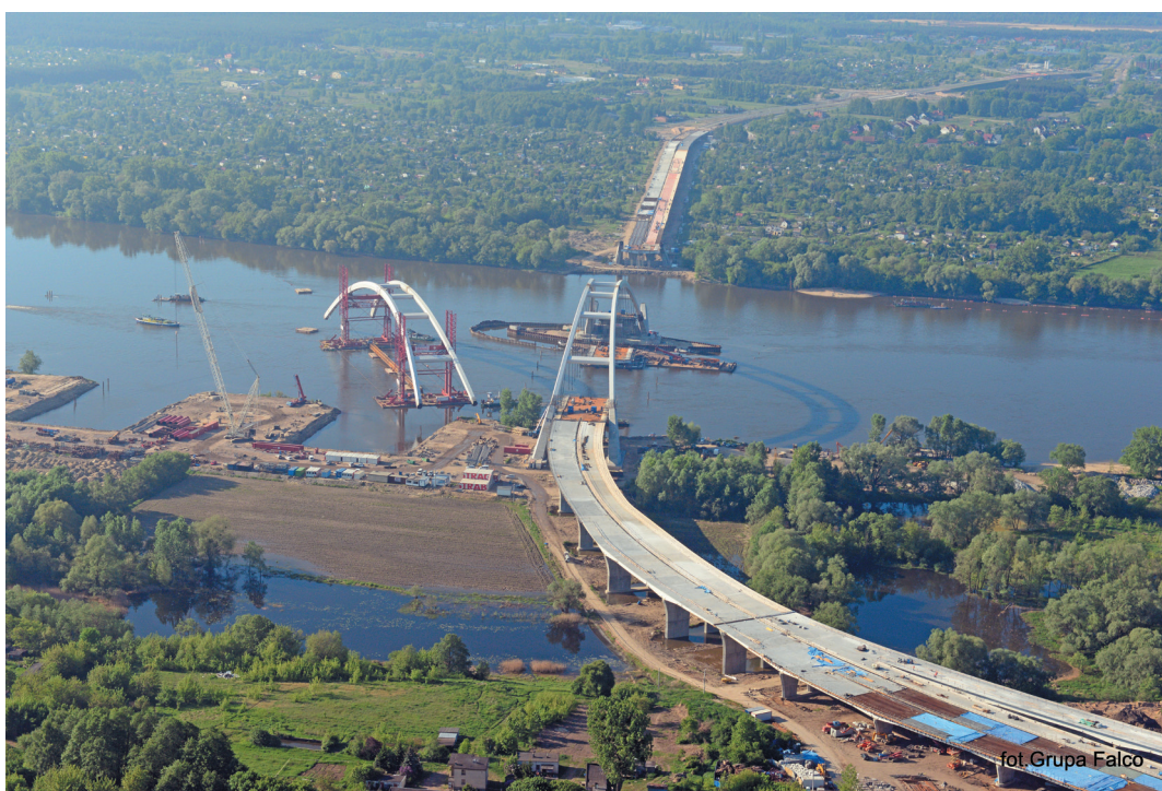
Fot. 6. Transport południowego przęsła nr 2 Źródło: Miejski Zarząd Dróg w Toruniu. Autor: Grupa Falco
