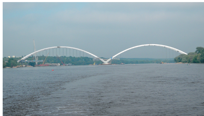
Fot. 3. Zamontowane przęsła nr 1 i nr 2 dźwigarów łukowych na podporach stałych. Przygotowania do montażu pomostu
