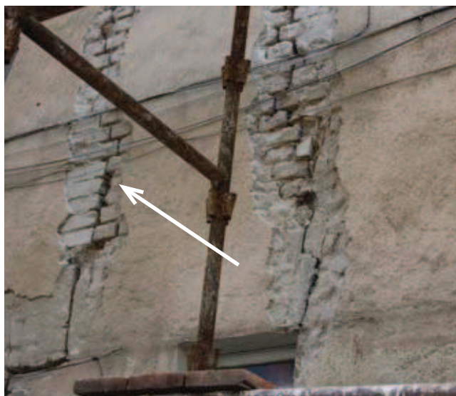
Rys. 2. Uzupelnienie muru cegłą bez przewiązki
