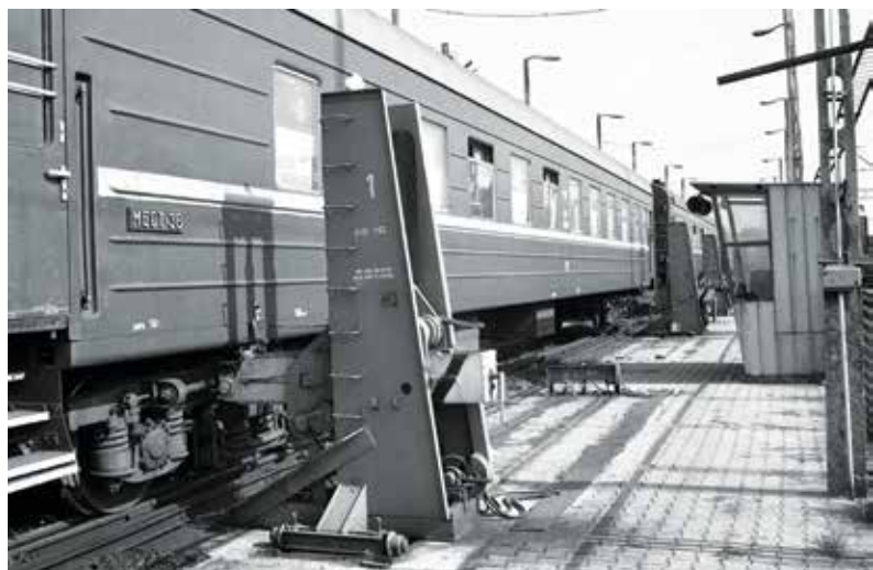
Konwencjonalne przestawianie wagonów pasażerskich pociągu Odesa–Warszawa na stacji Przemysłu (31.03.2000 r.). Fot. Ch. Amman
