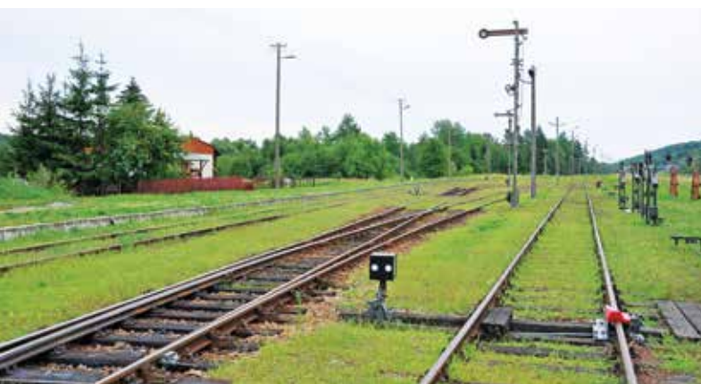
Stacja Werchrata zachodnia głowica wyjazdowa (27.07.2015 r.)
