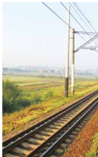
Odcinek Mościska 2–Mościska 1, splot toru 1435 mm i 1520 mm (10.09.2016 r.)
