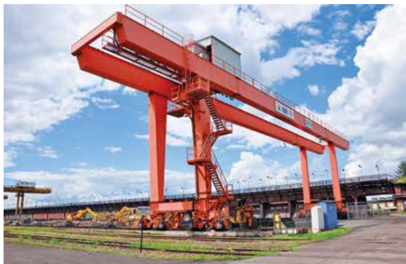
Suwnica bramowa na stacji w Medyce (28.07.2015 r.)
