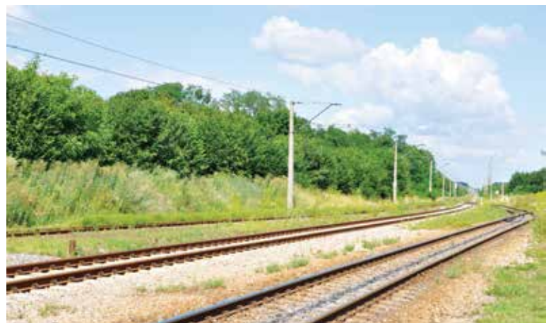
Wschodnia głowica wyjazdowa stacji Dorohusk (23.07.2016 r.)
