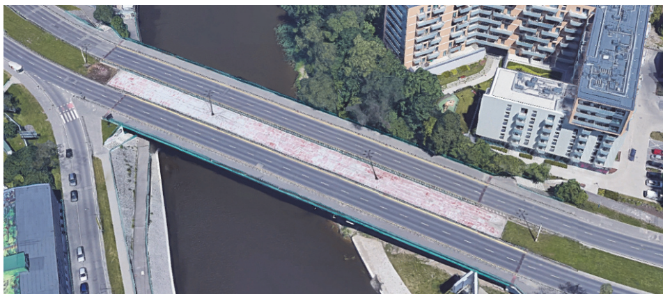
Rys. 1. Widok od strony południowej konstrukcji trzech mostów. W środku nieczynny most tramwajowy. Źródło: http://maps.google.com , dostęp: 24.04.2018 r.
