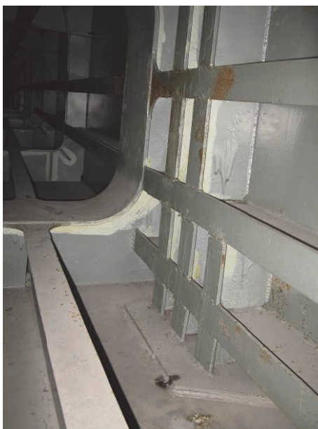
Rys. 5. Strefa wzmocnienia wyboycznej, pionowej ścianki dźwigara skrzynkowego
