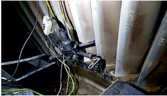
Rys. 3. Skaner PAUT do wrębów podczas badań stopnia L-0 – widok skanera w miejscu badania (montowany od strony wylotu pary).
