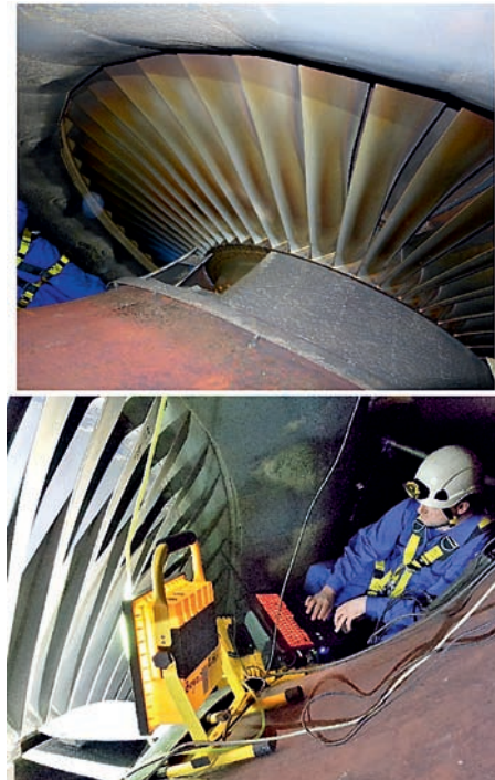
Rys. 2. Warunki pracy podczas badań w zamkniętej turbinie: a) okno w stożku osłaniającym wał wirnika, łopalki stopnia L-0, podesty robocze po obu stronach wału; b) operator z komputerem sterującym jednostką centralną PAUT i procesem skanowania wewnątrz układu przepływowego części NP.
