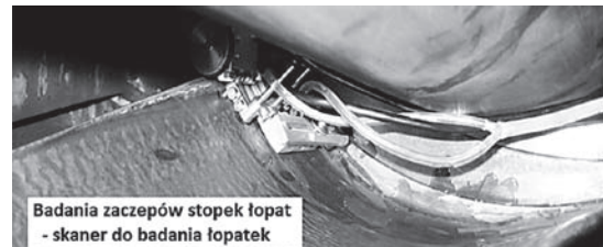
Rys. 5. Badanie stopek łopatek stopnia L-0 techniką PAUT w stanie zamontowanym.
