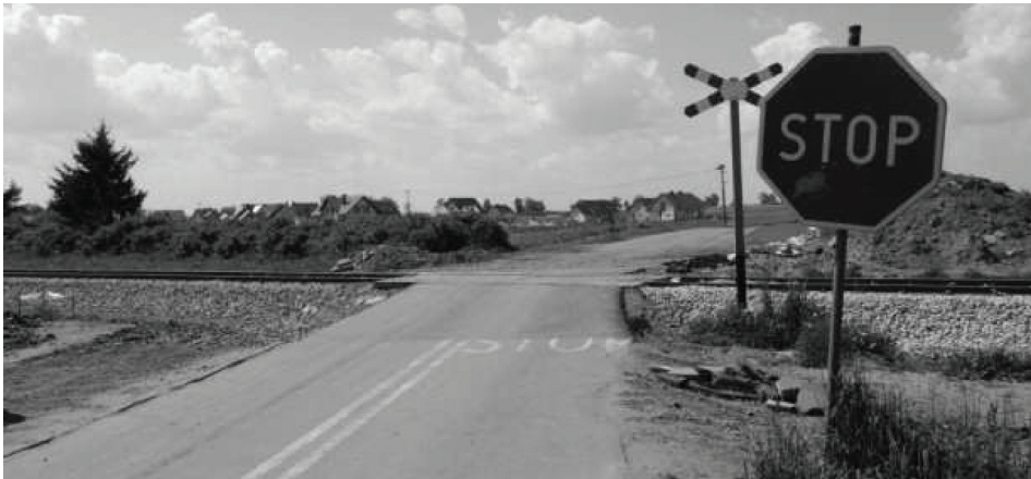
Rys. 4. Przejazd kategorii D na linii kolejowej nr 213 Reda – Hel
