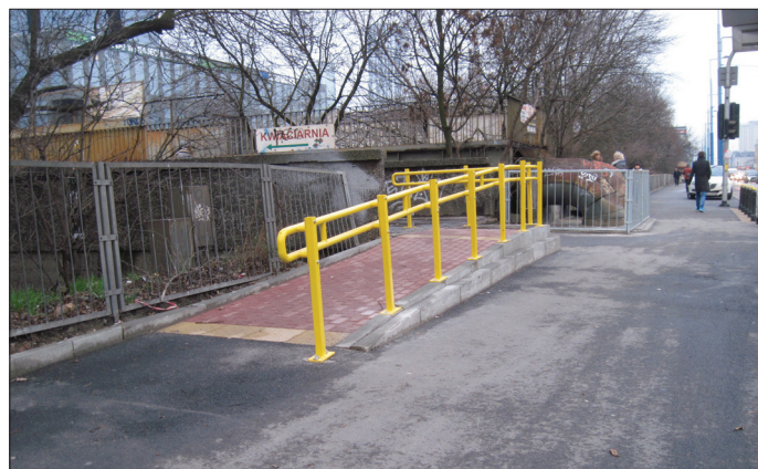
Fot.3. Wybudowana pochylnia
