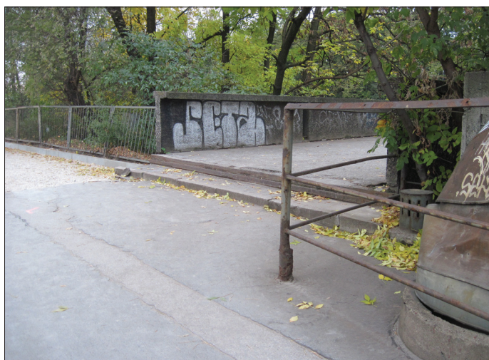
Fot.1. Wejście na kładkę przed przebudową
