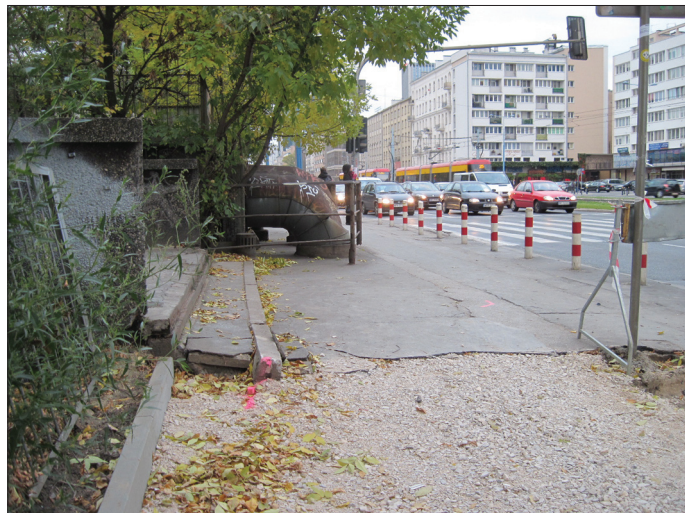
Fot.2. Widok na rury ciepłownicze
