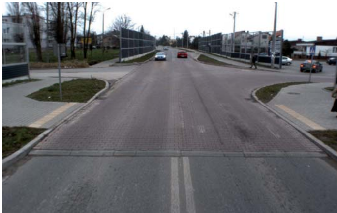
Fot. 4. Wyniesione skrzyżowanie w Piekoszowie (źródło: fotorejestracja DW 786 firmy TRANSCOMP, własność ŚZDW)
