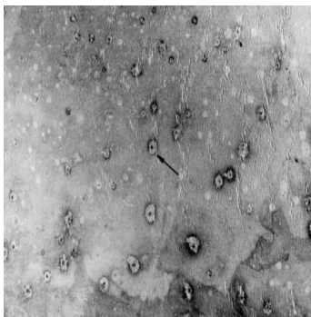
Fig. 7. Pitting corrosion [11] Rys. 7. Korozja wżerowa [11]
