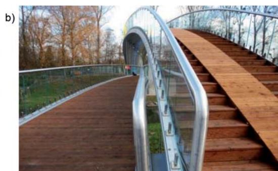
Fot. 4. Zakończenie prac budowlanych (14.11.2020): a) widok kładki od strony parku; b) drewniane pomosty i szklane balustrady
