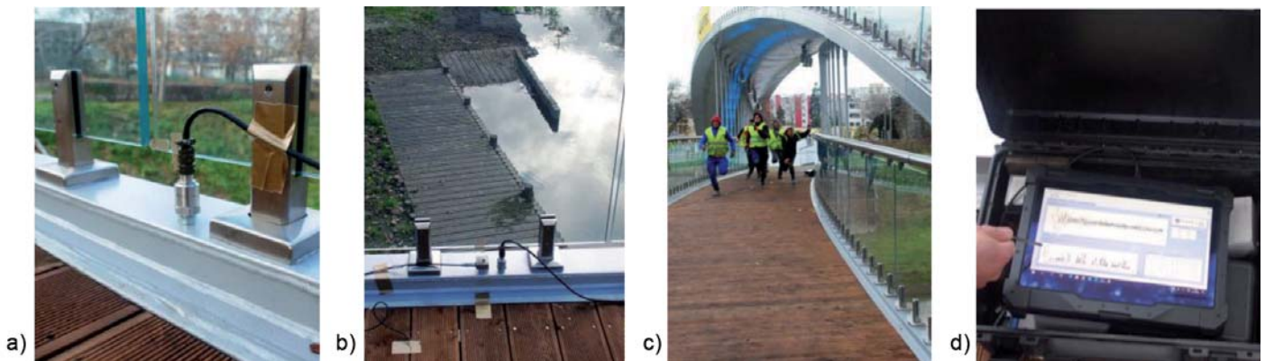
Fot. 6. Próbné obciążenie dynamiczne: a) i b) umiejscowienie akcelerometrów; c) sprint sześciu osób; d) rejestracja odczytów
