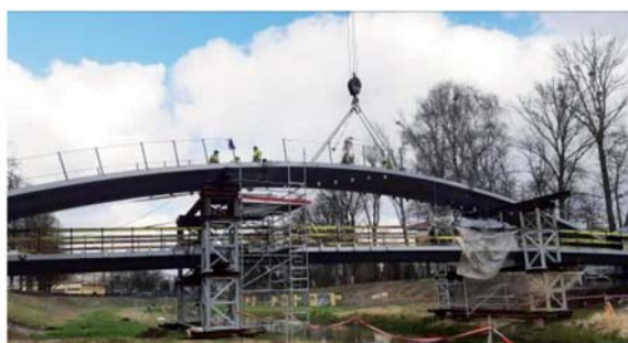
Fot. 2. Montaż i scalanie kładki na przyczółkach: a) i b) zewnętrzne podpory tymczasowe, zmontowany pomost dolny i montaż pomostu górnego; c) węzeł podporowy; d) stabilizacja szczeliny technologicznej do wykonania spawu czołowego
