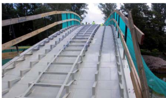
Fot. 3. Kładka po scaleniu z balustradami tymczasowymi (19.06.2020 r.): a) widok na pomost dolny; b) podpórki pod stopnie na pomoście górnym
