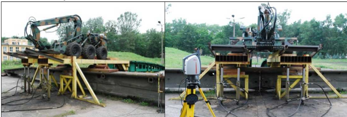
Rys. 3. Tymczasowa przeprawa mostowa typu BLG-67
