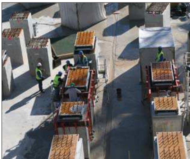
Fot. 3. Cadarache, budowa reaktora Georges Basse II, unikalna podstawa antysejsmiczna
