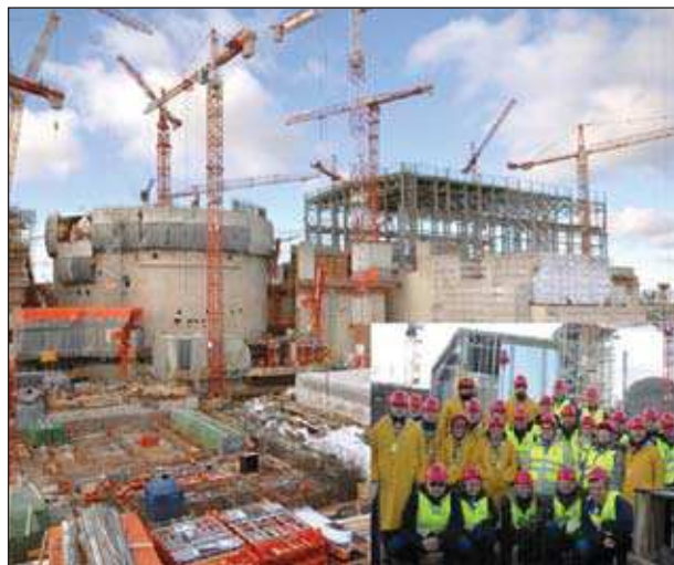
Fot. 6. Na budowie nowej elektrowni jądrowej z reaktorem EPR, Flamanville, 2009 r.
