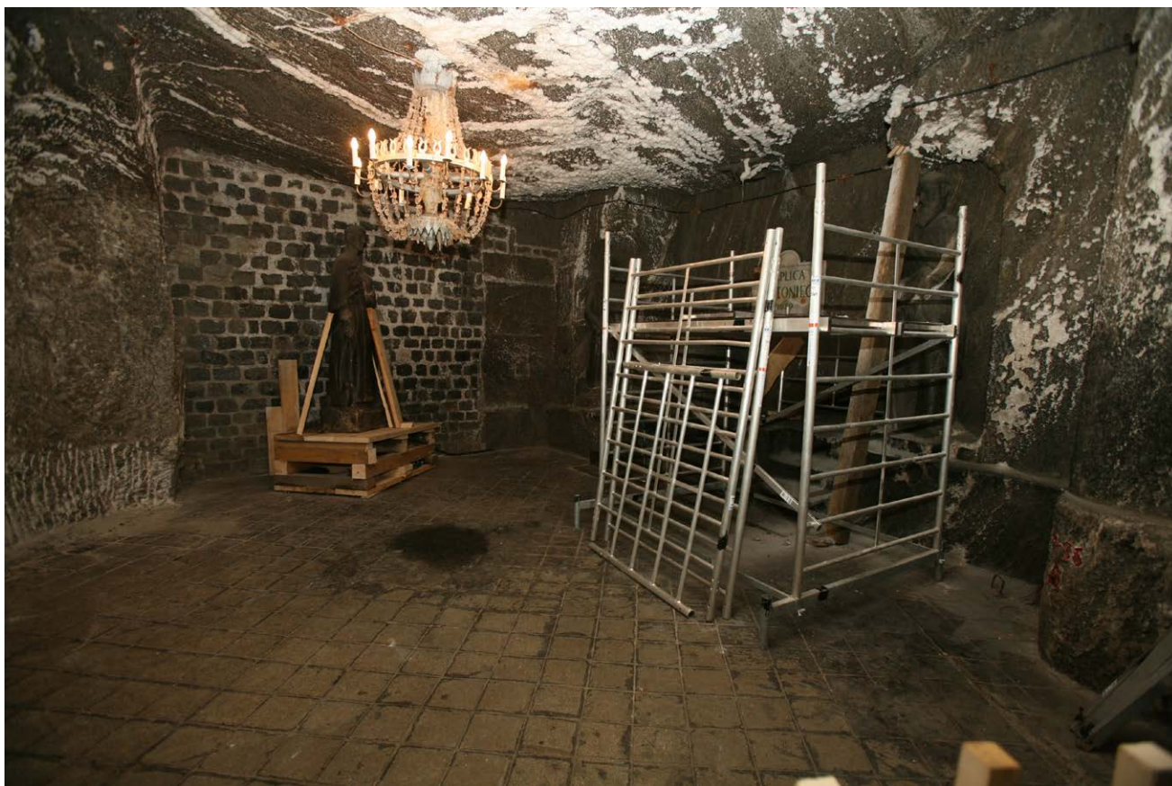
Rys. 10. Prace renowacyjne w 2006 r. (Św. Dominik na tle nieistniejącego już muru od strony podszybia szybu Daniłowicza).
