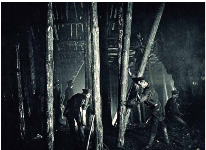
Wykonywanie drewnianej obudowy filaru
