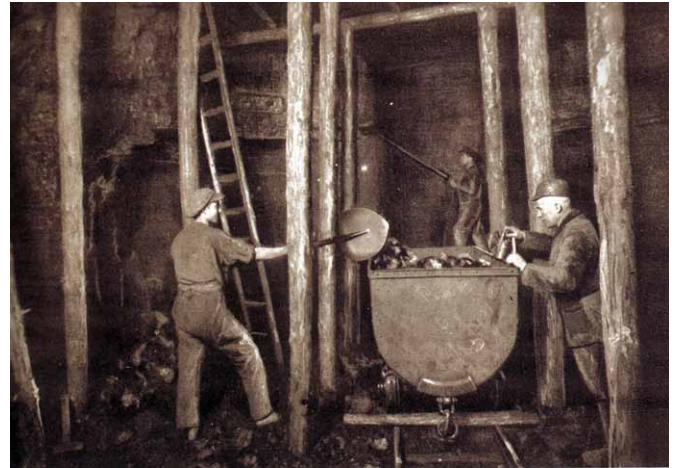
Ręczne ładowanie urobku do wozów
