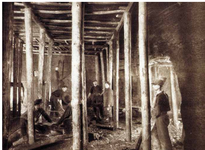
Wykonywanie obudowy drewnianej w wyrobisku filarowym
