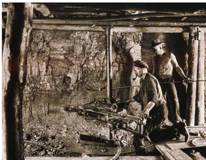
Wykonywanie wrębu pneumatyczną wrębiarką żerdziową
