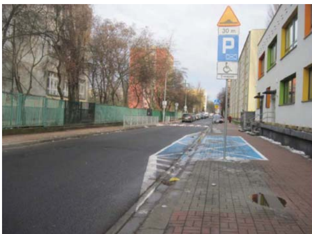
Fot. 5. „Koperty” czytelnie wyznaczone oznakowaniem poziomym i pionowym nie utrudniają ruchu pieszych i ruchu kołowego
