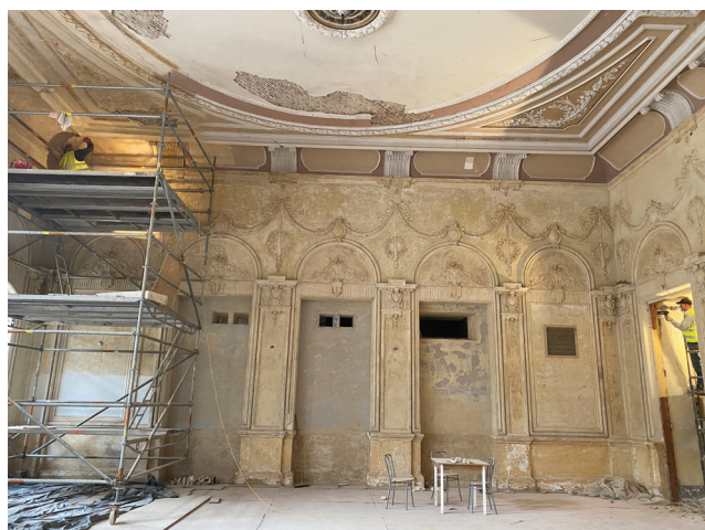
Fot. 2. Ściana zachodnia – widok na otwory do projektorów filmowych; źródło: fot. własna
