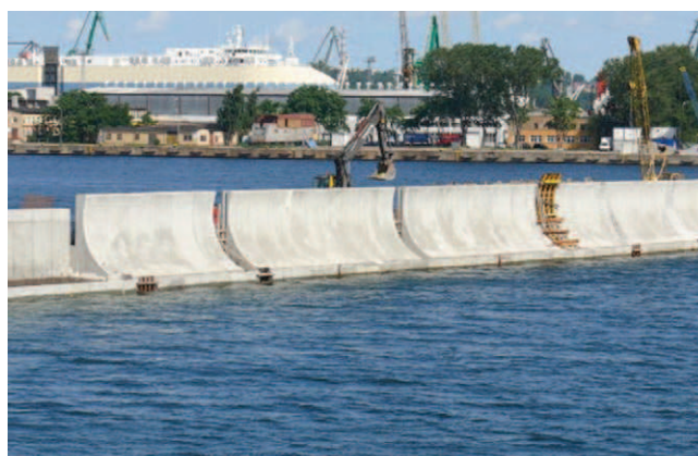
Fot. 6. Prefabrykowane „łamacze fal” ustawione na poszerzonej konstrukcji falochronu
