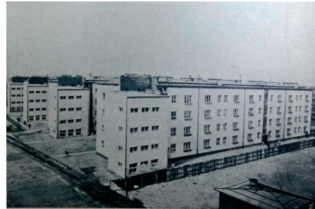
Rys.4. Widok na bloki mieszczące pralnie i łazienki połączone suszarniami w budynkach przy ul. Kobielskiej. [15]
