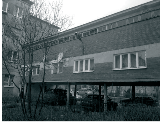
Rys. 9. Wtórnie wybite otwory okienne w trakcie adaptacji łączników na mieszkania, fot. K. Matysiak Fig. 9. Secondary window holes stamped in the course of adapting the connectors for housing
