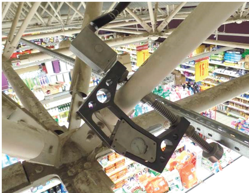
Rys. 2. Widok twardościomierza PZ-3 podczas pomiaru twardości rury stanowiącej krzyżulec przekroczenia strukturalnego
