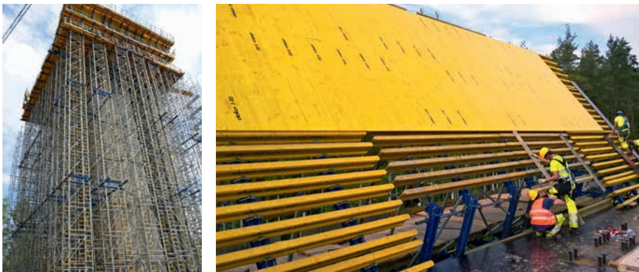
Ryc. 2. Podparcie oraz deskowanie jednego z trzech segmentów startowych MS-3
