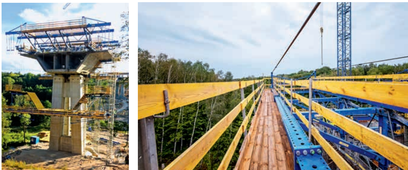
Ryc. 3. Urządzenia CFT w czasie montażu, z prawej strony widoczne opomostowanie bhp
