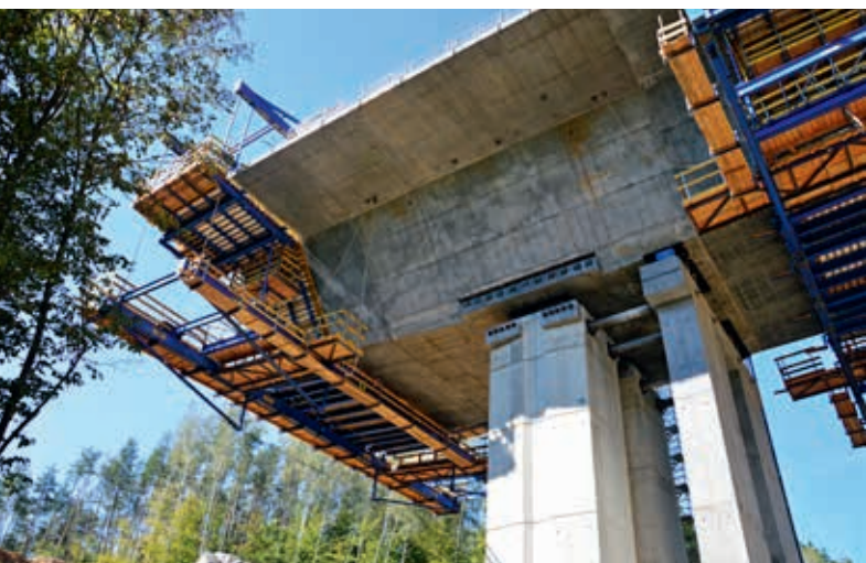
Ryc. 4. Zmontowane urządzenia CFT w czasie realizacji segmentów obiektu MS-3 metodą nawisową
