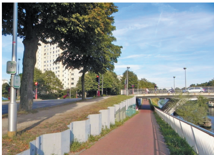
Fot. 1. Quasi tunel rowerowy w mieście Gent, Belgia Źródło: zdjęcie autorów
