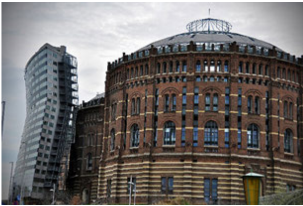
1b.1. Wiedeń. Gazometr B z przybudowanym akademikiem. Widok od frontu. Fot. aut.
