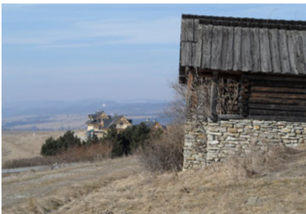
1a.5. Kluszkowce. Przeniesiona piwniczka (kamień) – lamus (drewno), w głębi nowy pensjonat. Fot. aut.
