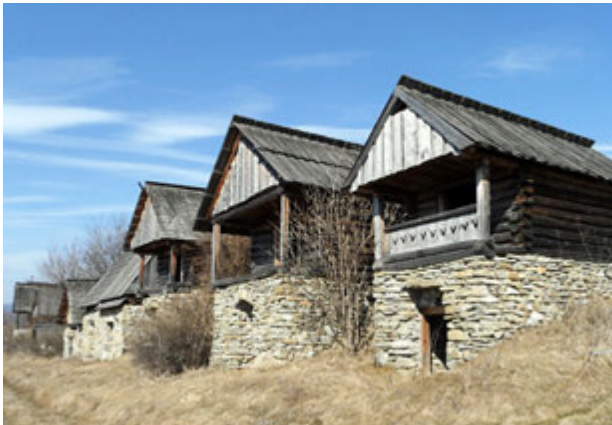
1a.3. Kluszkowce. Przeniesione piwniczki (kamień) – lamusy (drewno). Fot. aut.
