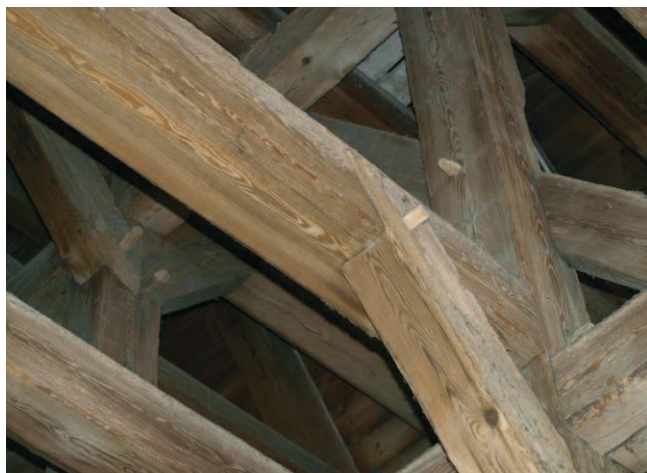
Rys. 10. Unikatowe połączenie ciesielskie – widok z dołu więźby
