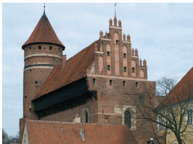
Rys. 1. Zamek w Olsztynie. Hurdyca na całej długości połaci dachu. Pod połacią analizowana struktura drewna więźby dachowej
