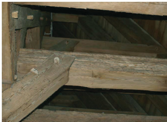
Rys. 11. Unikatowe połączenie ciesielskie – widoczne połączenia na kolki
