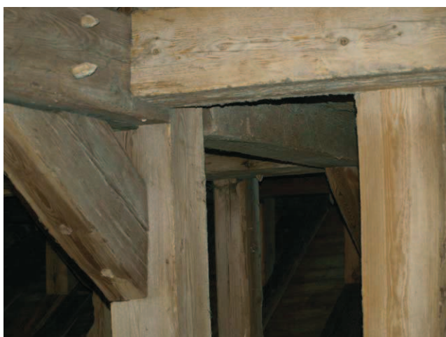
Rys. 9. Unikatowe połączenie ciesielskie – belka-stolec-miecz
