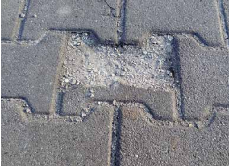
Fot. 2. Uszkodzenia warstwy licowej kostki brukowej spowodowane destrukcją mrozową betonu warstwy konstrukcyjnej
