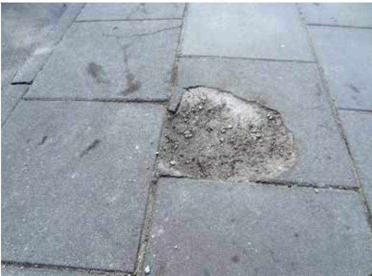
Fot. 3. Uszkodzenia warstwy licowej betonowej płyty chodnikowej spowodowane destrukcją mrozową betonu warstwy konstrukcyjnej
