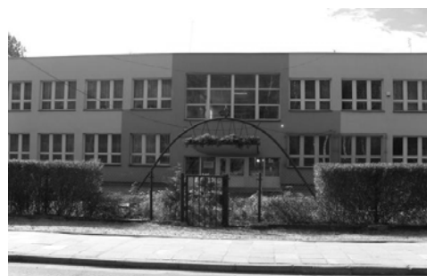
Fot. 6. Budynek szkoły po termomodernizacji (fot. J. Malikowski, 2007).
