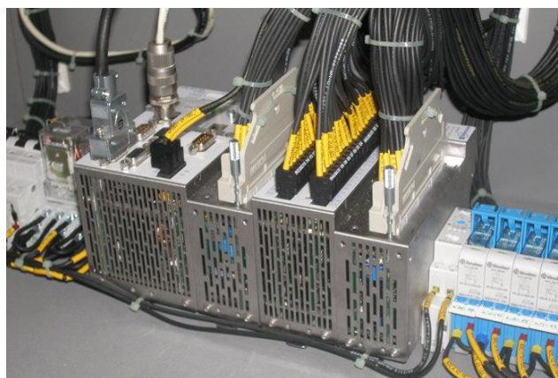
Rys. 1. Sterownik PLC i moduły rozszerzeń symulatora
