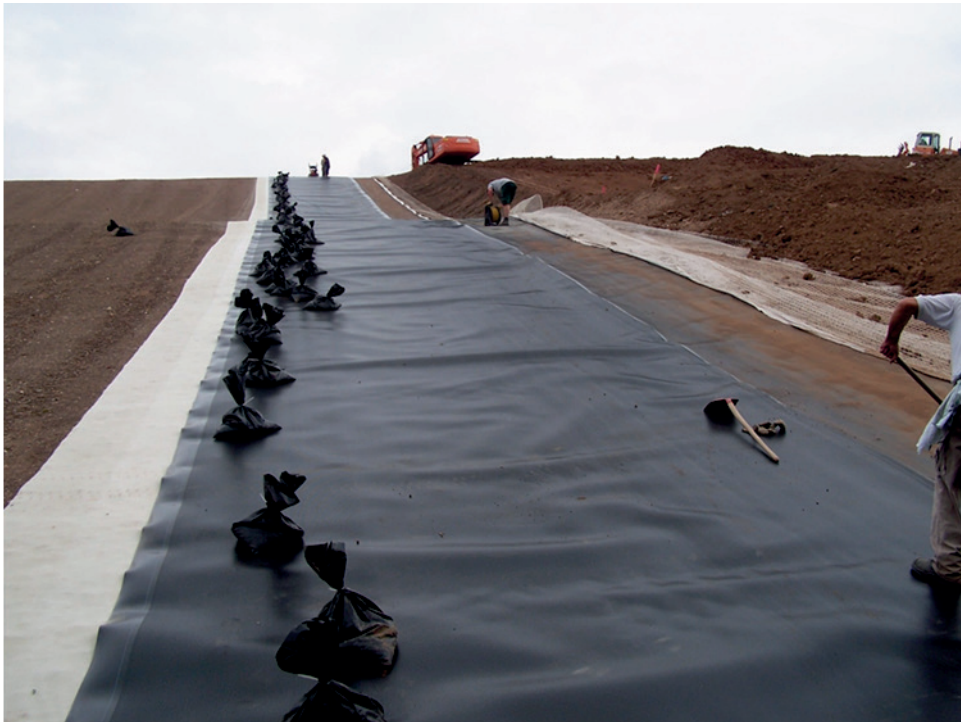
Fig. 2. Covering the slope with waterproofing materials Rys. 2. Pokrywanie stoku materiałem hydroizolacyjnym
