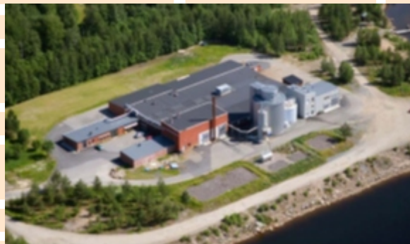
Rys. 6. Biogazownia w Boden.
