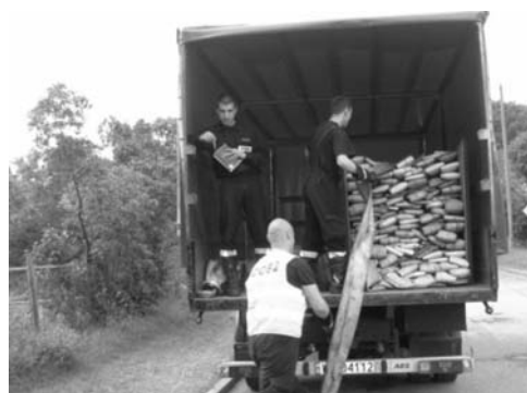
Rys. 4. Sprawianie linii zasilającej W110 z improwizowanego samochodu wężowego wyposażonego w koryto
