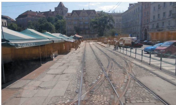
Fot. 2. Widok torowiska na obrzeżu targowiska w Poznaniu. Fot. Cz. Wolek
