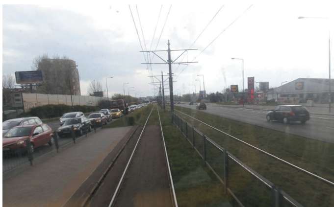
Fot. 4. Widok torowiska zlokalizowanego pomiędzy jezdniami w Warszawie. Fot. Cz. Wolek
