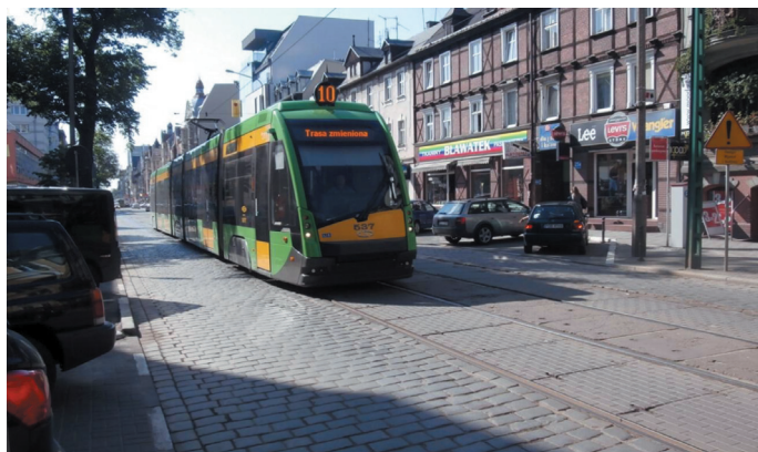
Fot. 1. Widok torowiska wtopionego w konstrukcję nawierzchni w staromiejskiej zabudowie w Poznaniu. Fot. Cz. Wolek
