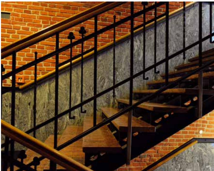
Fot. 9. Detale klatki schodowej; źródło: fot. M. Janiak
