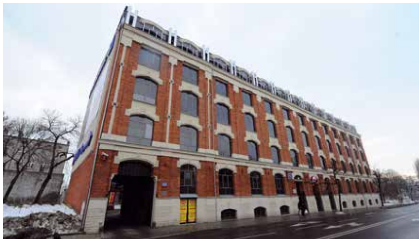
Fot. 4. Elewacja zachodnia, frontowa – stan po rewitalizacji; źródło: fot. M. Janiak
