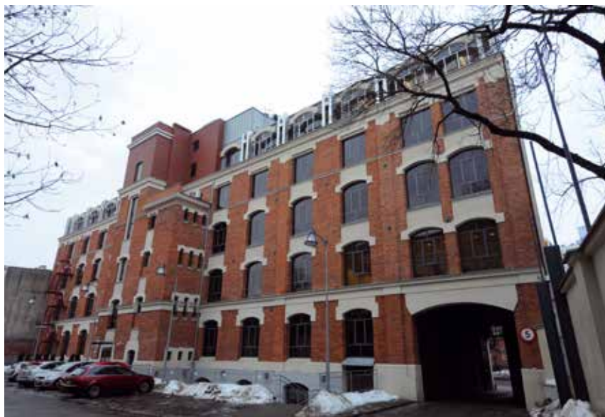
Fot. 5. Elewacja wschodnia, tylna – stan po rewitalizacji; źródło: fot. M. Janiak
