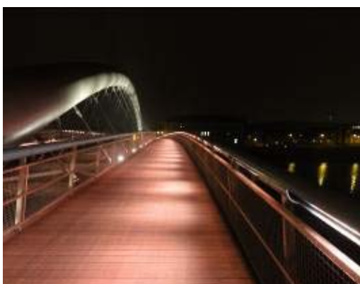
Ryc. 15. Nocny widok na pieszo-rowerową kładkę Bernatkę prowadzącą z Kazimierza do Podgórza.
