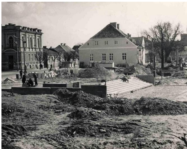
Rys. 4. Wykonywanie bloku fundamentowego i ścian oporowych pod pomnik Władysława Broniewskiego, źródło: Muzeum Mazowieckie w Płocku
