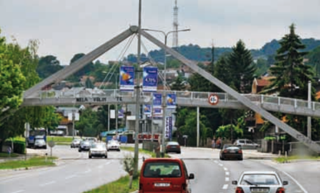
Ryc. 4. Kładka podwieszona przy wjeździe do Banja Luki
