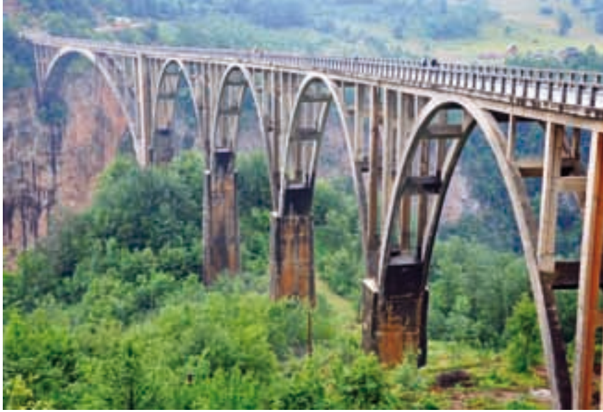
Ryc. 22. Pięcioprzęsłowy żelbetonowy most łukowy przez Tarę
