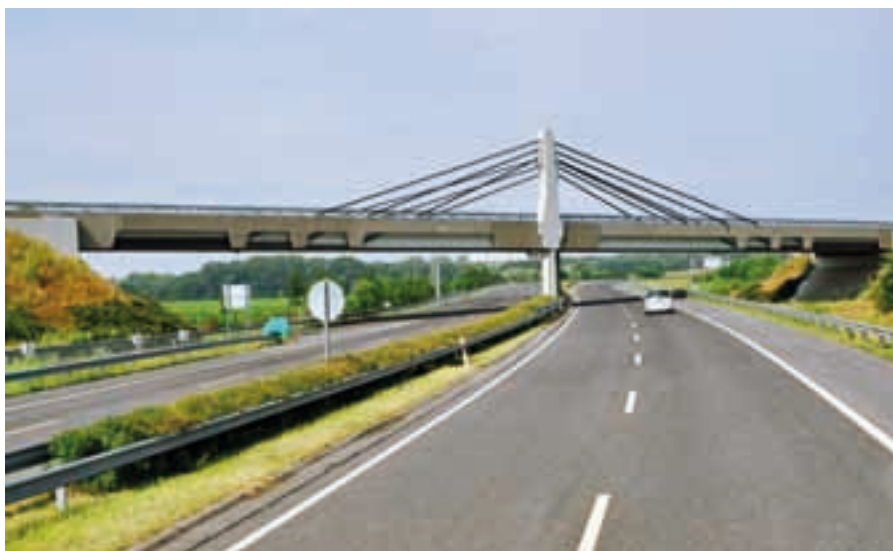
Ryc. 2. Kładka podwieszona nad autostradą na odcinku Nagykanizsa – Letenye
