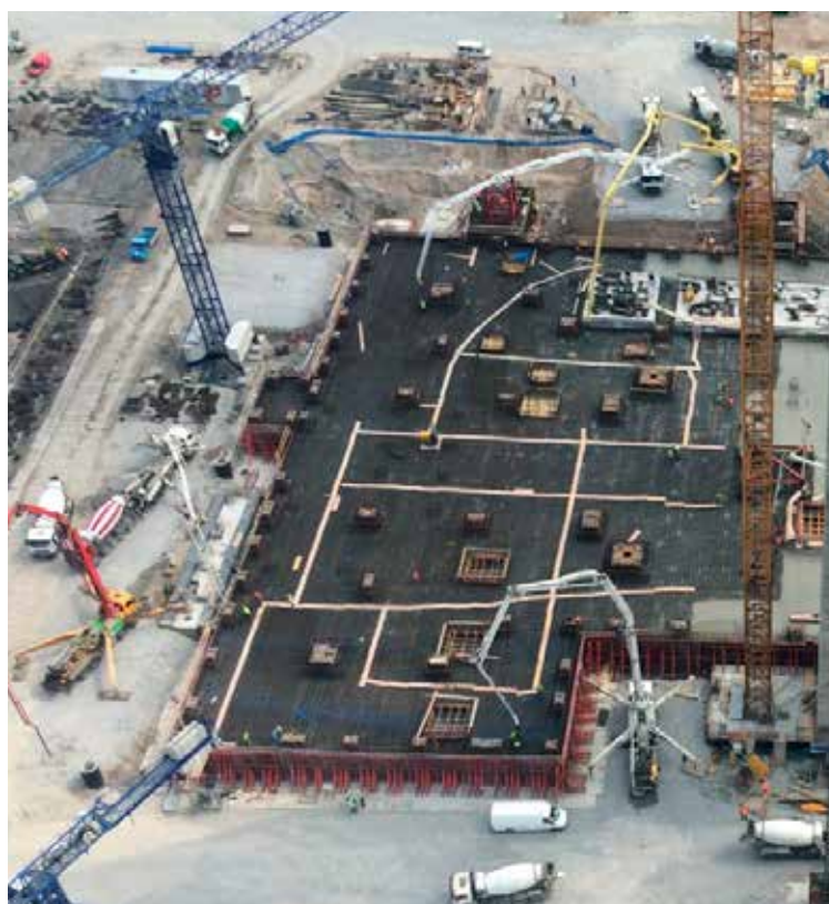
Fot. 1. Zabudowa betonu w konstrukcji masywnej
