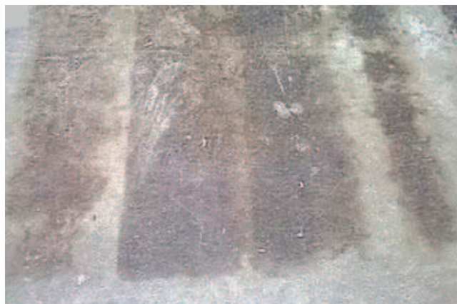
Rys. 6. Przykłady występowania uszkodzeń wywołanych obciążeniami chemicznymi
