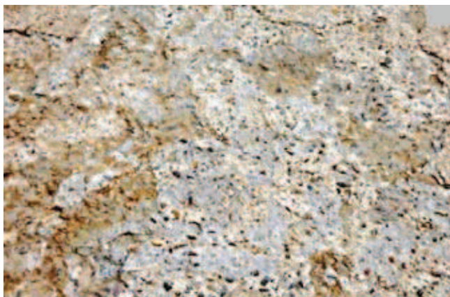
Rys. 6. Przykłady występowania uszkodzeń wywołanych obciążeniami chemicznymi
