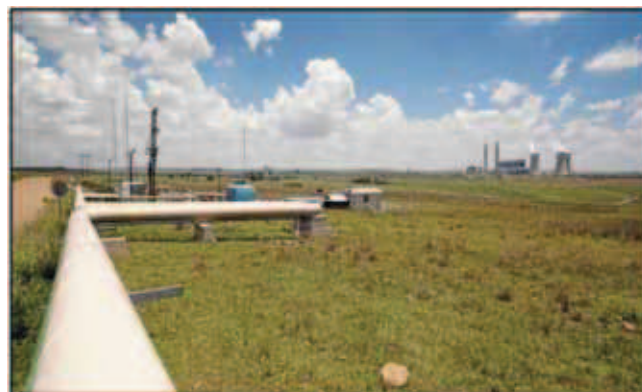
Rys. 7. Instalacja PZW w elektrowni Majuba w Mpumalanga Fig. 7. Majuba UCG project at the Majuba power station in Mpumalanga
